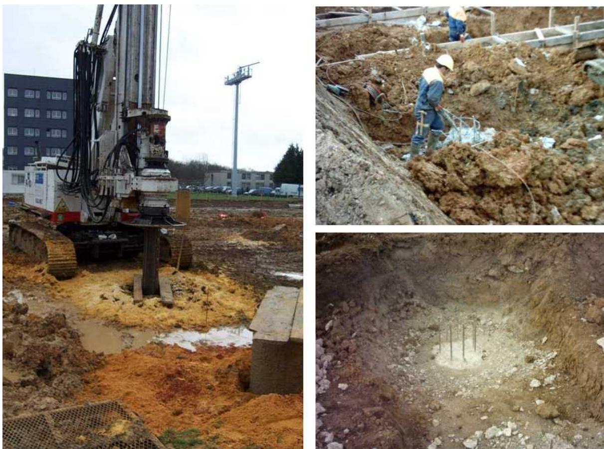
*fig. n°1.21- Coulage à la tarière, recépage, et tête de pieu recépage*
