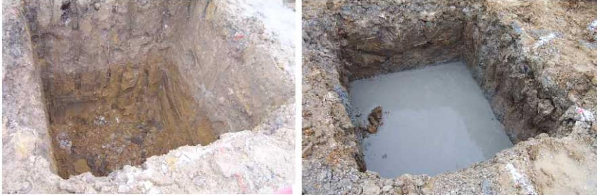
fig. n°1.20- Fouille et coulage d'un puits en gros béton
