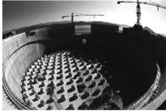
fig. n°7.25- Réservoir sur isolateurs parasismiques
