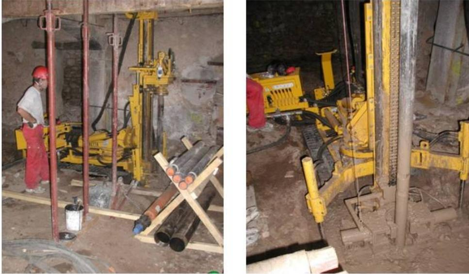
fig. n°1.24– Exemple de mise en œuvre d'un micro pieu
